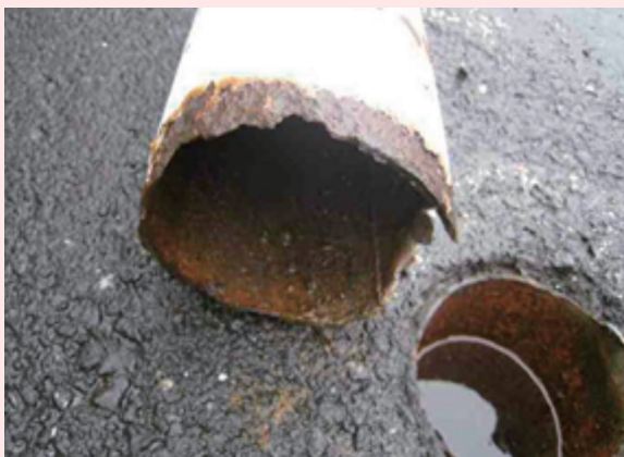
ポールの根腐れによる倒壊
