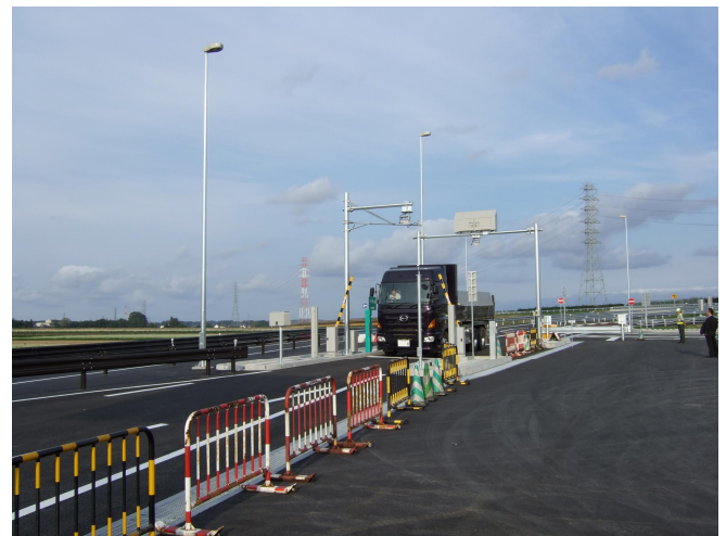
下り線オフランプの状況
