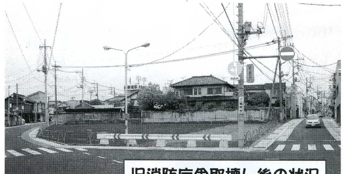
旧消防庁舎取壊し後の状況
