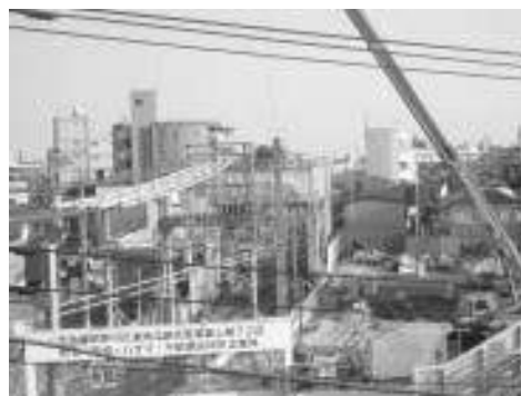
<京急蒲田工事現場①>
