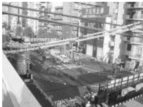
<京急蒲田工事現場②>
