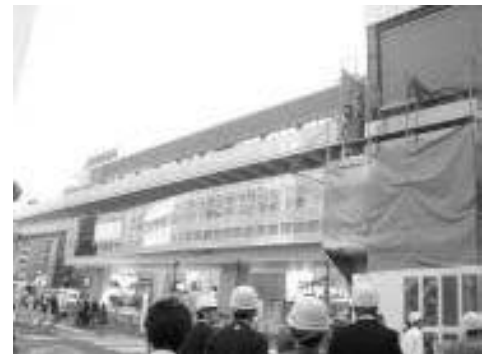
&lt;日暮里舎人線工事現場&gt;
