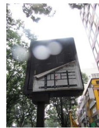
シート材がはがれかかった状態
