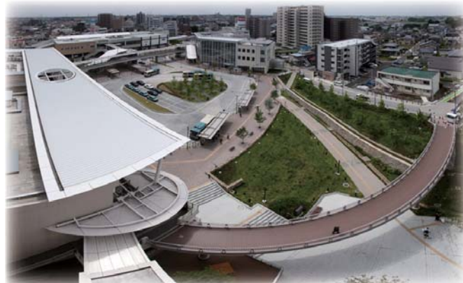
駅から左右の施設に伸びる安全で快適な歩行者デッキ
