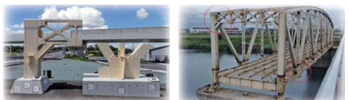
水府橋モニュメント設置事業（水戸市）
