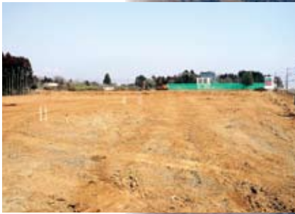
▲北側街区の造成工事
