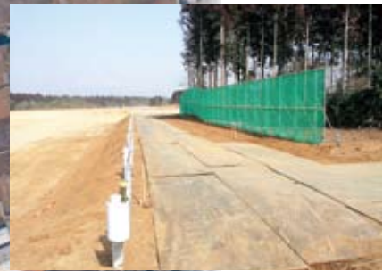
△道路築造工事(南側区画道路)
