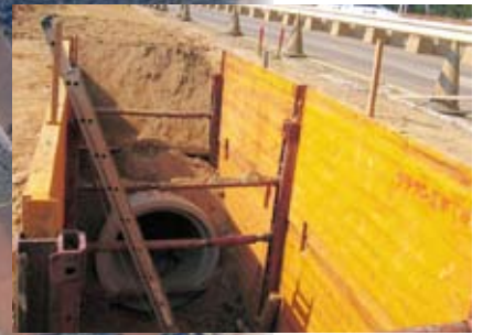
△供給処理管の敷設工事(薬師山通り線)
