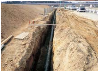
▲供給処理管の敷設工事(追原・久野線)
