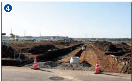
区画道路築造(16、17、18、24街区周辺)
