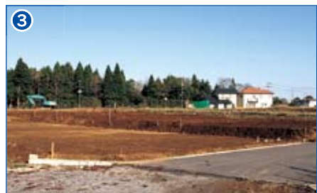
区画道路築造(1、2、4街区周辺)
