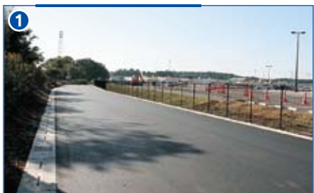
区画道路築造(A-1、A-2街区周辺)
