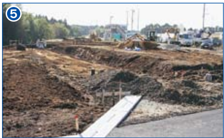
区画道路築造(33-2街区周辺) (各工事現場撮影日:平成23年10月27日)
