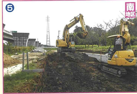
地区外アプローチ道路整備
