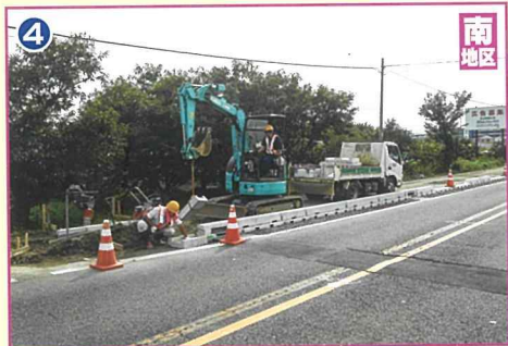
道路築造工事
