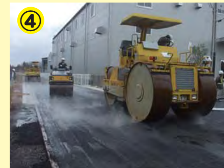
地区南側の区画道路工事の様子
