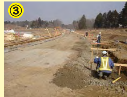
上河原崎西環状線の道路工事の様子
