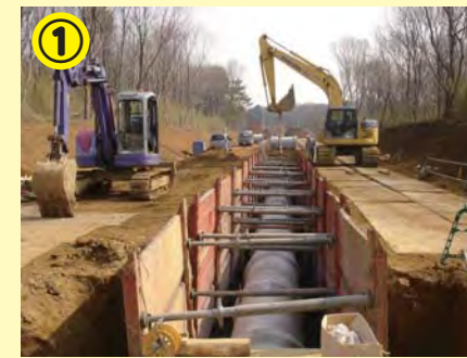
下水道開削工事の様子
