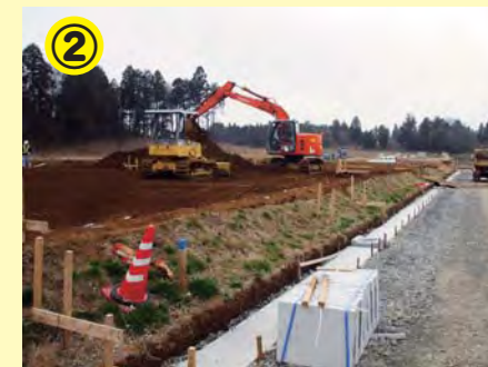
上河原崎西環状線西側の宅地整形工事の様子
