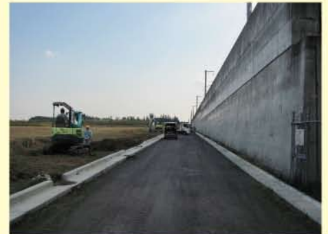
②つくばエクスプレス沿いの区画道路工事の様子
