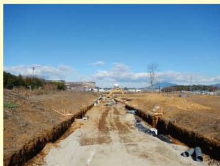
③大規模緑地北側の区画道路工事の様子
