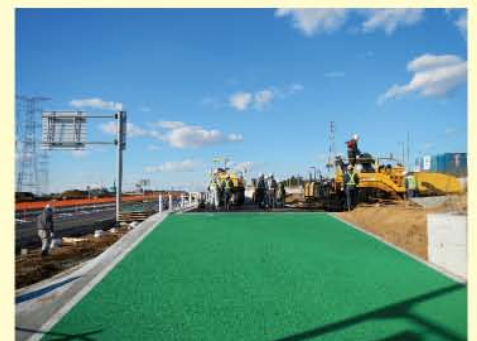
④新都市中央通り線沿いの区画道路工事の様子
