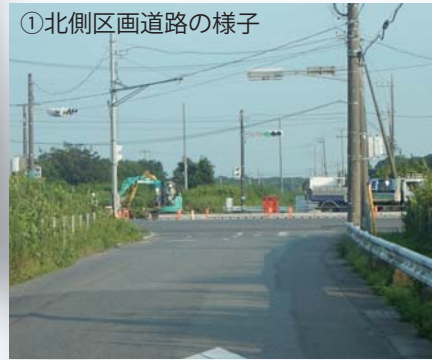
②県道土浦坂東線バイパスの様子
