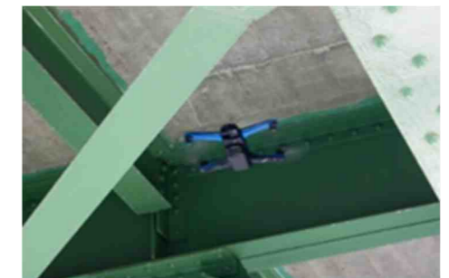
写真3 新技術の活用例(ドローン点検)
