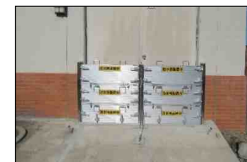
写真 5 防水板の設置状況
