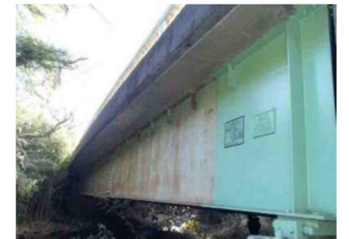
写真2 部分塗装の実施例
