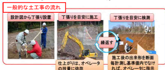
図3 建設現場作業の現状
