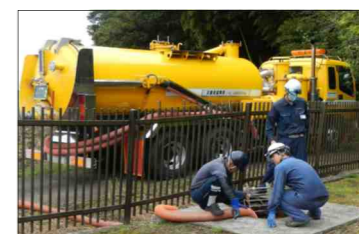
写真 8 汚水受入れ状況
