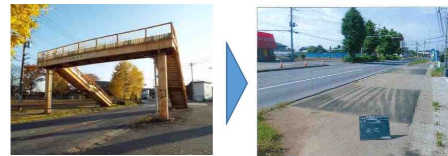
写真5 横断歩道橋の撤去事例
