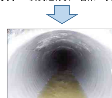
写真 7 管更生工事後の状況
