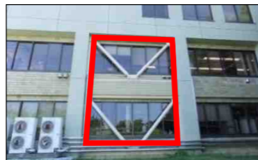
写真 1 耐震対策の状況
