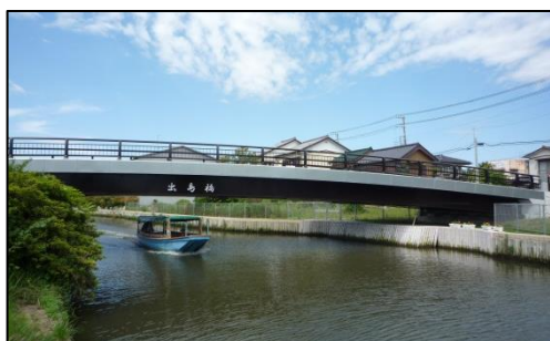
【前川 出島橋（竣工後）】
