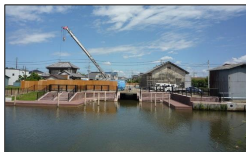
【津軽河岸跡親水護岸（竣工後）】
