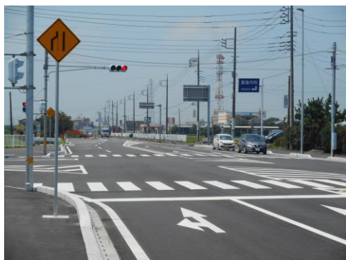
【交差点（改良工事後）】
