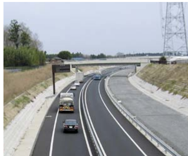
平成24年度の県内区間全線開通を目指す圏央道
