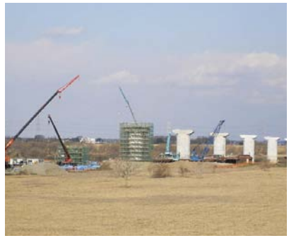
圏央道利根川渡河橋工事((仮)五霞IC~(仮)境IC間)
