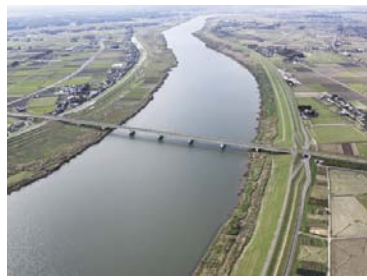
アクセス道路の整備が進む若草大橋
