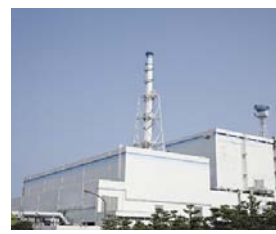
東海第二発電所(東海村)
