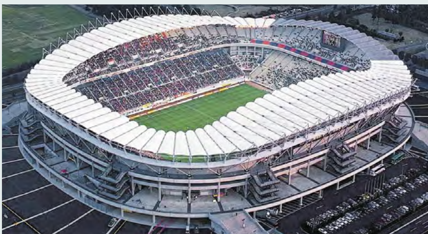
県立カシマサッカースタジアム(鹿嶋市)
