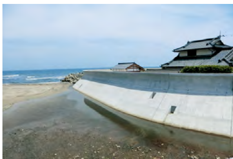
災害に強い県土づくり(日立市小木津海岸の堤防かさ上げの様子)
