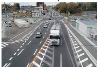
整備が進む国道294号(取手市)
