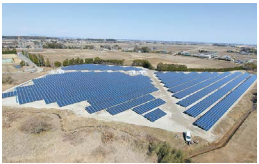
県内に設置されている太陽光発電施設
