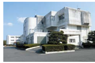
県立消防学校(茨城町)
