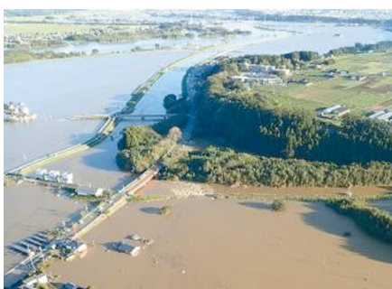
那珂川などの氾濫により浸水した水戸市飯富・藤井・岩根地区
