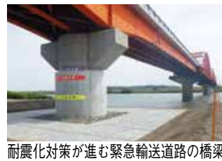
耐震化対策が進む緊急輸送道路の橋梁
