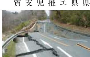
東日本大震災の影響による地割れや崩落で破損した道路(那珂市田崎)
