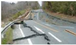
東日本大震災の影響による地割れや崩落で破損した道路(那珂市田崎)
