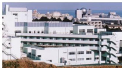
（株：日立製作所日立総合病院）
