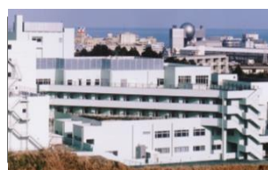
（株：日立製作所日立総合病院）
