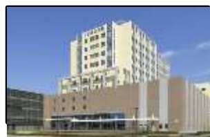
（株：日立製作所日立総合病院）
