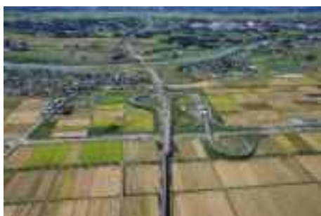
首都圏中央連絡自動車道 常総 I C 周辺地区
