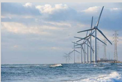
洋上風力発電の導入 (出典：(株)ウィンド・パワー)
