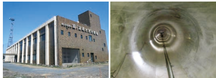
○霞ヶ浦導水事業 (左:霞ヶ浦導水那珂機場、右:那珂導水路)
