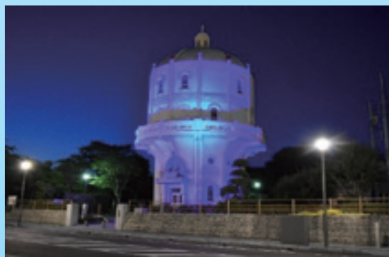
水戸市水道低区配水塔
