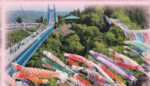
常陸太田市電神大吊橋
