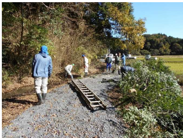
農道砂利敷きと支障木の伐採
