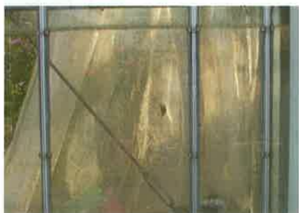
▲▼ このような隙間が暖房効率を上げています。
