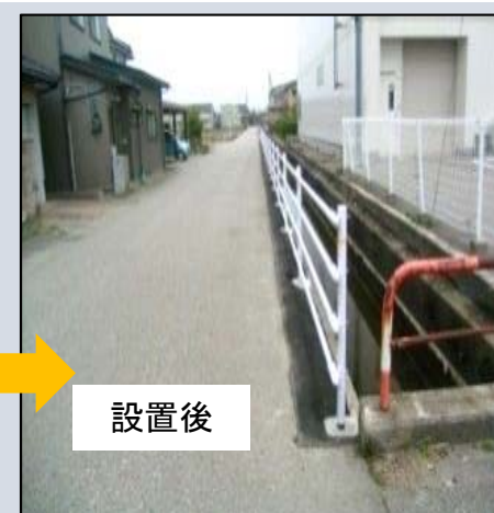
＜水路沿線の混住化に伴う転落防止柵の設置＞
