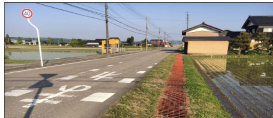
＜用水路の管理に配慮した蓋かけの施工事例（多面的機能支払活動組織による対応）＞
