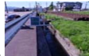
事故現場での現地調査
