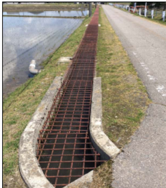
＜用水路の管理に配慮した蓋かけの施工事例（多面的機能支払活動組織による対応）＞
