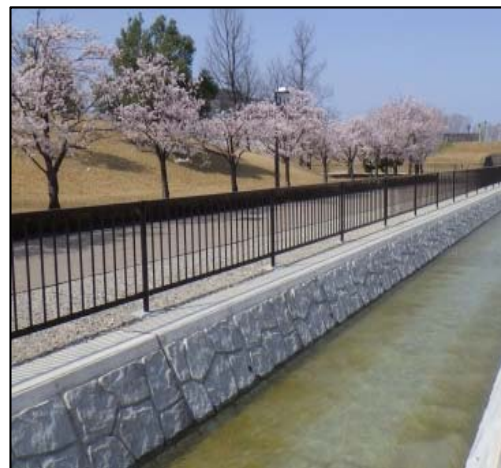
＜基幹水路沿いの転落防止柵の設置＞
