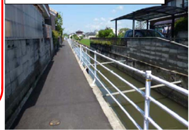
転落防止柵を設置した事例
