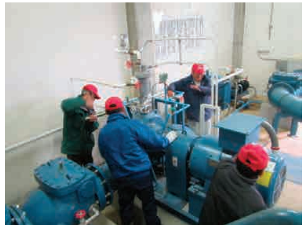
揚水試運転・施設の整備
