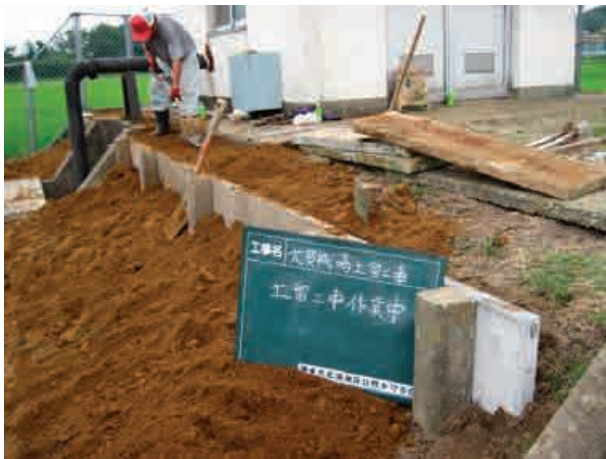
機場周辺の土留め工事
