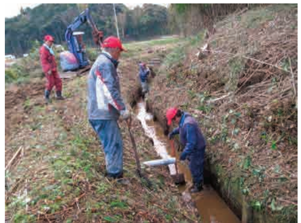
排水路の一斉泥上げ
