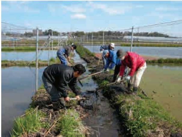
水路の泥上げ
