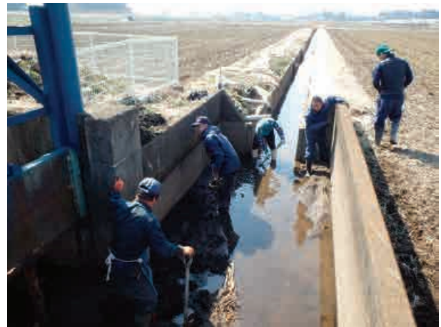
機場・水路の泥上げ
