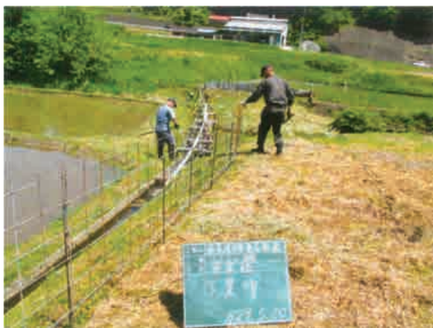
ワイヤーメッシュ柵の設置
