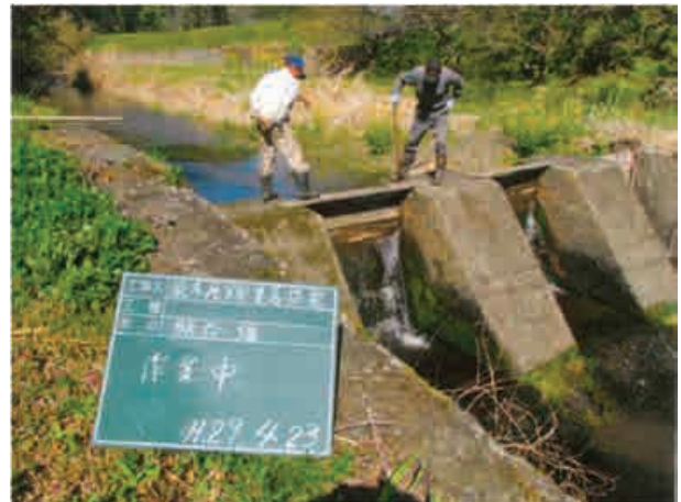
用水路の泥上げ
