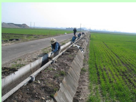
用水路の泥上げ
