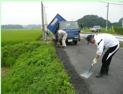
③：農道の初期補修
