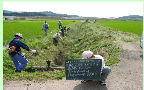
②：水路の草刈り
