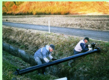
⑤：腐食防止材の塗布
