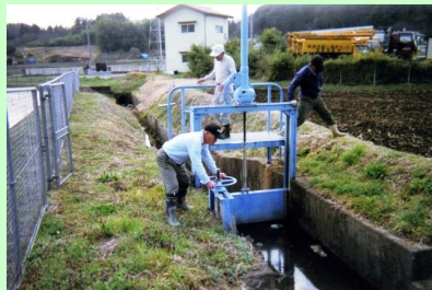
①：農業用施設の点検
