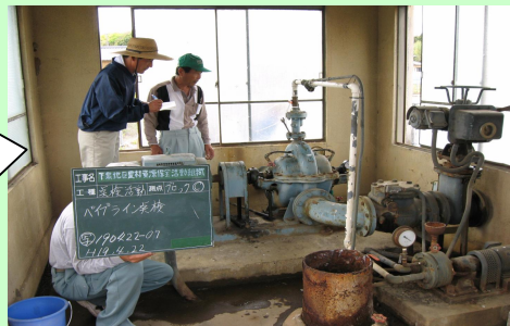
①：施設の点検
