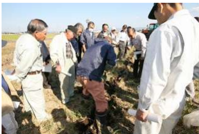
現地検討：施工後の土中の籾殻を確認
