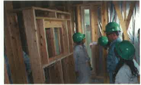
建築中の住宅の様子
