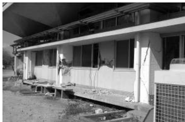
水戸農業高等学校 寄宿舍食堂棟
