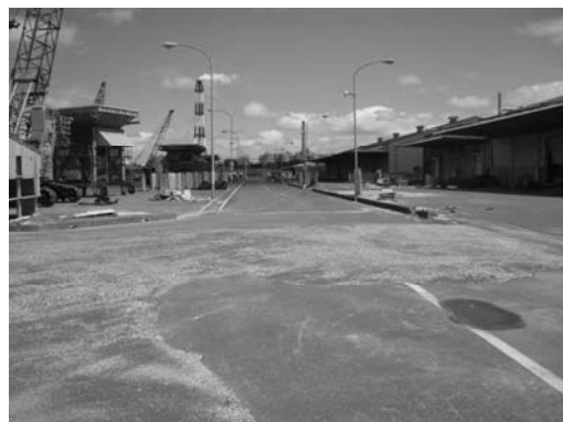
(鹿島港南公共ふ頭地区) 応急復旧状況
