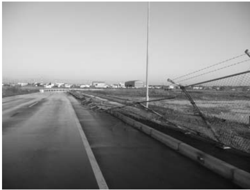
（鹿島港北公共ふ頭地区） 被災直後
