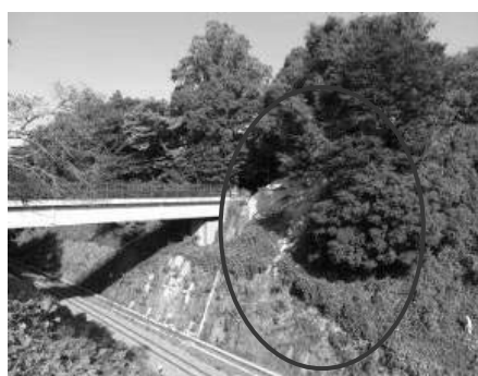
水戸第一高等学校校地 法面応急復旧工事
