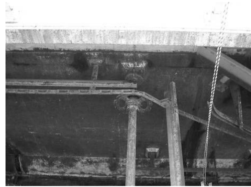
汚泥掻寄機応急復旧後
