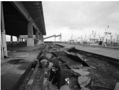
大津漁港 市場施設
