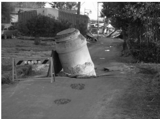
常陸太田市：マンホールの浮き上がり
