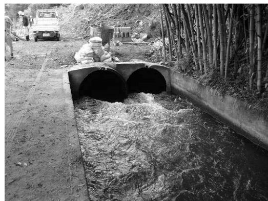
仮設水路を設置し5月22日通水
