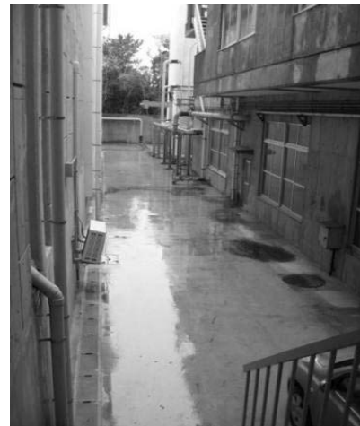
液状化（沈砂池建物周辺）復旧状況
