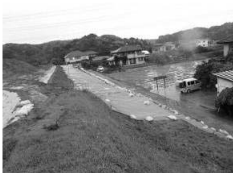
潮来高等学校校地 応急復旧工事
