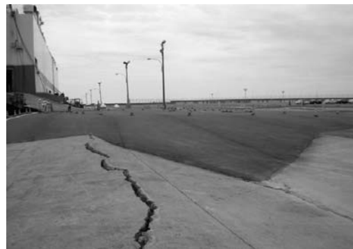
日立港区5ふ頭地区応急復旧状況
