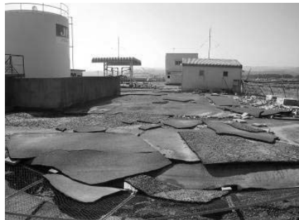
波崎漁港 給油施設
