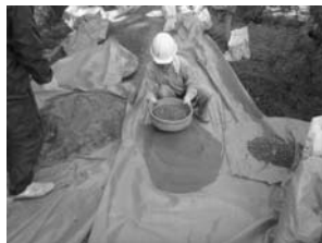
黄土壁の材料精製状況（乾燥・ふるい分け作業）
