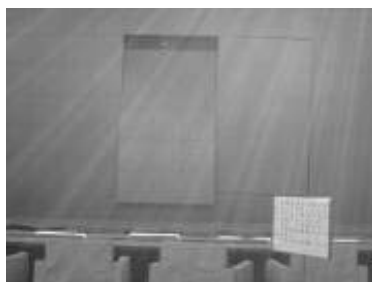
図書館：木壁パネルの脱落
