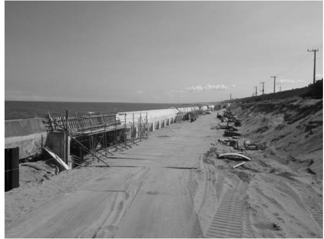
大洗町成田：工事進行中
