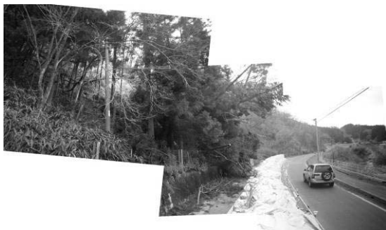
山腹崩壊地の応急措置：土のう設置
