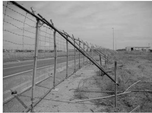
（鹿島港北公共ふ頭地区） 有刺鉄線によるソーラスフェンス復旧
