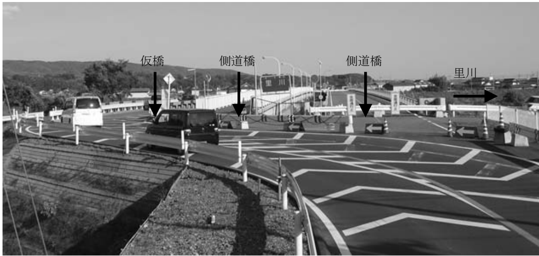
仮橋にて通行止め解除
