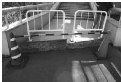
分館西側通路（橋）
