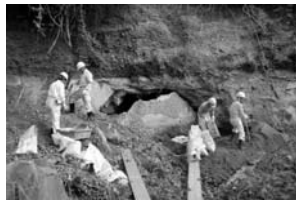
黄土壁の材料採取状況（水戸市備前町）
