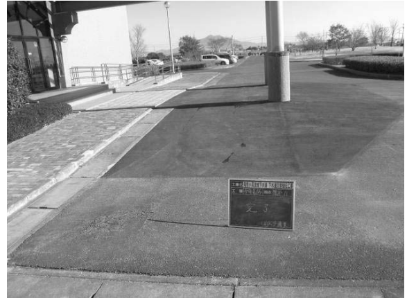
管理棟 玄関前復旧完了状況
