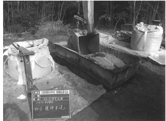
常陸太田市：埋戻土を改良強化
