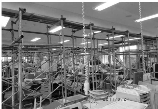
執務室 応急支保工
