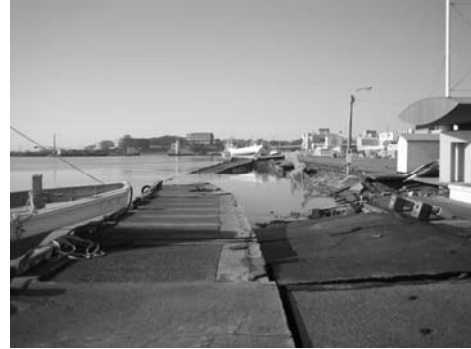
那珂湊漁港 -5m岸壁の崩落
