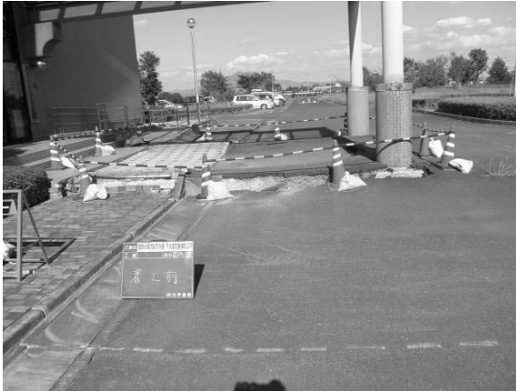
管理棟 玄関前応急復旧状況
