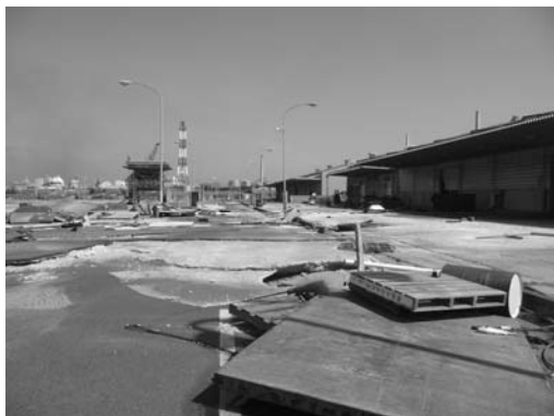
(鹿島港南公共ふ頭地区) 被災直後
