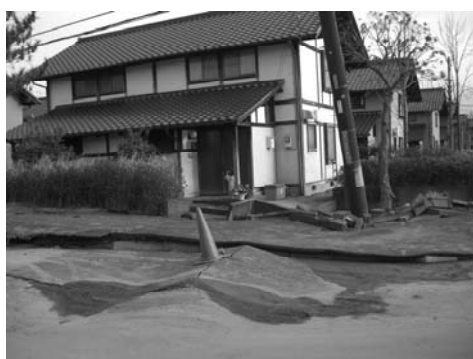
傾いた日の出住宅液状化被害状況
