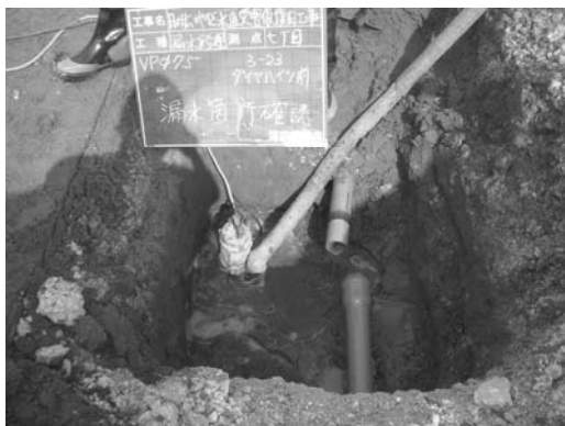
水道管の復旧工事
