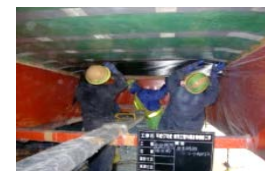
炭素繊維シートによる補修
