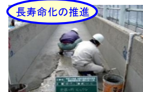
開水路の補修
