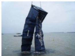
東日本大震災における航路再開状況
