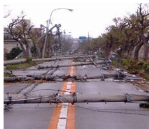
電柱の倒壊による 道路閉塞
