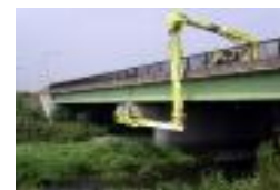
橋梁点検車を使った橋梁点検
