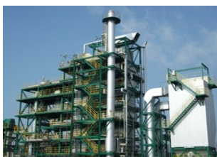
木質バイオマス発電所
