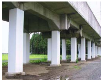
【鋼板巻きによる耐震対策】
