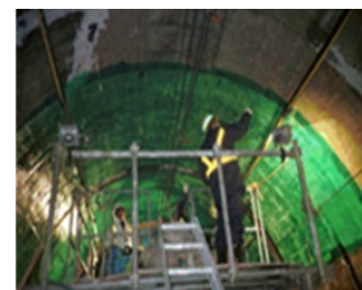
【繊維シート貼り付けによる老朽化対策】
