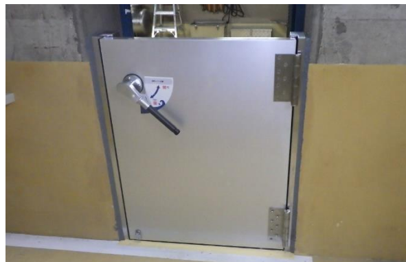
止水板の設置例
