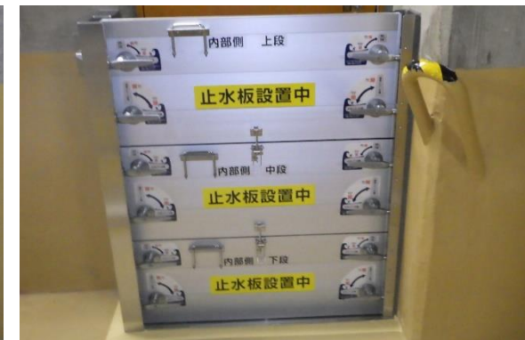
止水板の設置例
