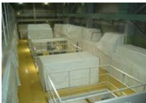
廃棄物を鋼板で覆う (シートで覆われている箇所)
